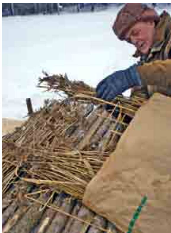
7. Den färdiga flottan förses med ett lager vass som säkras med två längsgående slonor.
