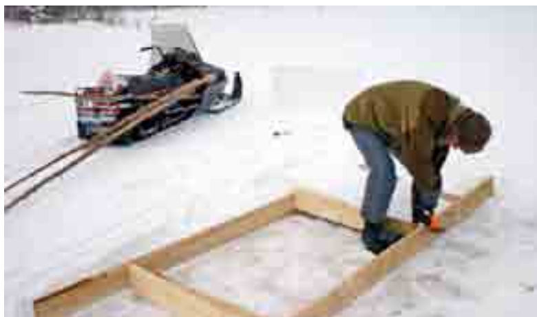
1. Börja med att spika ihop ramen till flotten...
