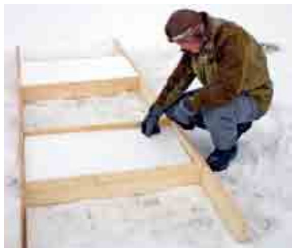
3. Spika därefter fast tunna granslanor som golv. Låt slanorna sticka ut cirka 50 centimeter på vardera sidan.
