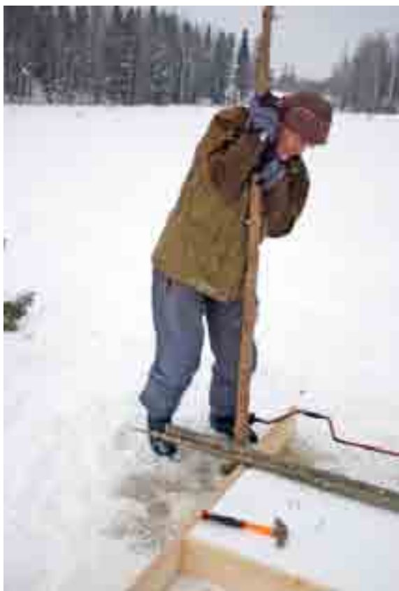
4. Borra sedan hål i isen med en isbör och driv ner stolpar i de hörn som bildats mellan granslanorna och flottens långreglar.
