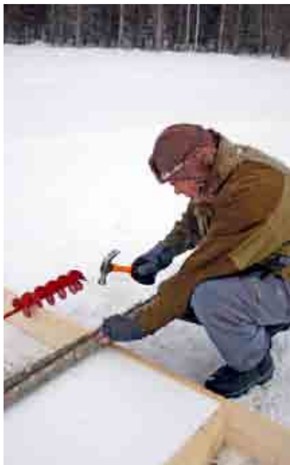
3. Spika därefter fast tunna granslanor som golv. Låt slanorna sticka ut cirka 50 centimeter på vardera sidan.
